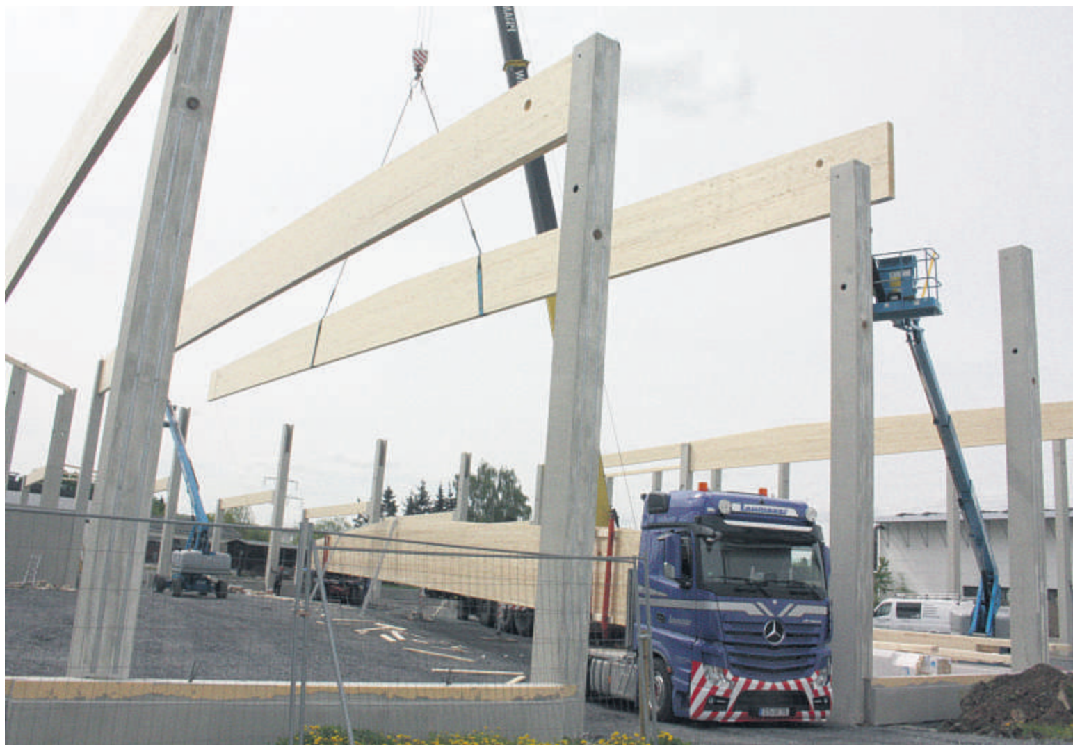
Nur zehn Minuten pro Riesen-Rippe brauchte der Kran, um die Dachkonstruktion der neuen Honsel-Halle zusammenzufügen.
